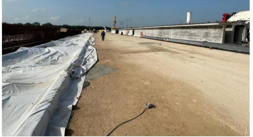
Após o despejo do concreto você tem que esperar um período de uma hora, após este tempo o vapor será aplicado em um tempo de 3 a 4 horas. Uma vez que a temperatura de 85°C o controle de qualidade realiza ensaios em amostras de concreto para determinar suas características mecânicas, neste ponto o gerador de vapor irá a baixo calor para manter a temperatura de 85°C será mantida até atingir a resistência necessária para o concreto.
