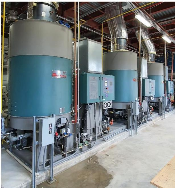
Os equipamentos de umidificação são divididos em duas grandes famílias, dependendo da fonte que fornece a energia para vaporizar a água, e cada uma afeta a temperatura do ar de uma maneira diferente. Usando adiabáticos, o ar é resfriado. Com isotermia, a temperatura do ar permanece constante. Os primeiros utilizam o calor do ar que está sendo umedecido, enquanto os segundos utilizam o calor que é adicionado à água destinada à umidificação.
