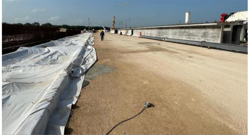
Después del vaciado del hormigón se tiene que esperar un lapso de una hora, después de este tiempo se aplicará vapor en un tiempo de 3 a 4 horas. Una vez alcanzada la temperatura de 85°C control de calidad realiza pruebas en muestras del concreto para determinar sus características mecánicas, en este punto el generador de vapor de pasara a fuego bajo para mantener la temperatura de los 85°C será mantenida hasta alcanzar la resistencia requerida para el hormigón.
