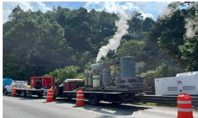
El sistema de encamisado de tuberías sin obras mediante manga consiste en la introducción por inversión de una manga impregnada con resina de tipo poliéster o epoxi en el interior de la tubería mediante
