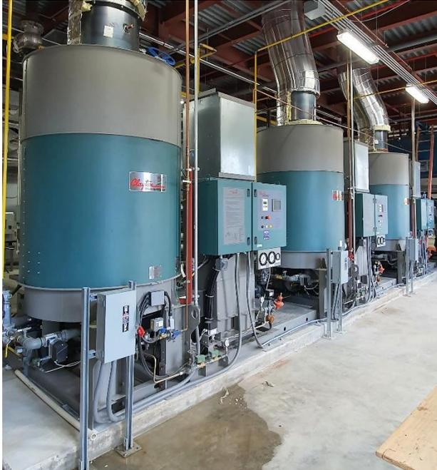
Los equipos de humidificación se dividen en dos grandes familias, dependiendo de la fuente que provee la energía para vaporizar el agua y cada una afecta de diferente manera la temperatura del aire. Utilizando adiabáticos, el aire se enfría. Con los isotérmicos la temperatura del aire permanece constante. Los primeros utilizan el calor del aire que está siendo humidificado, mientras que los segundos emplean el calor que es agregado al agua destinada a la humidificación.
